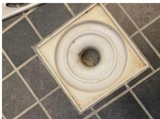
Gitter vom Abfluss vorsichtig aushebeln/öffnen (z.B. mit einem Schraubenzieher)
